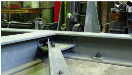
(d) Brace to main beams
